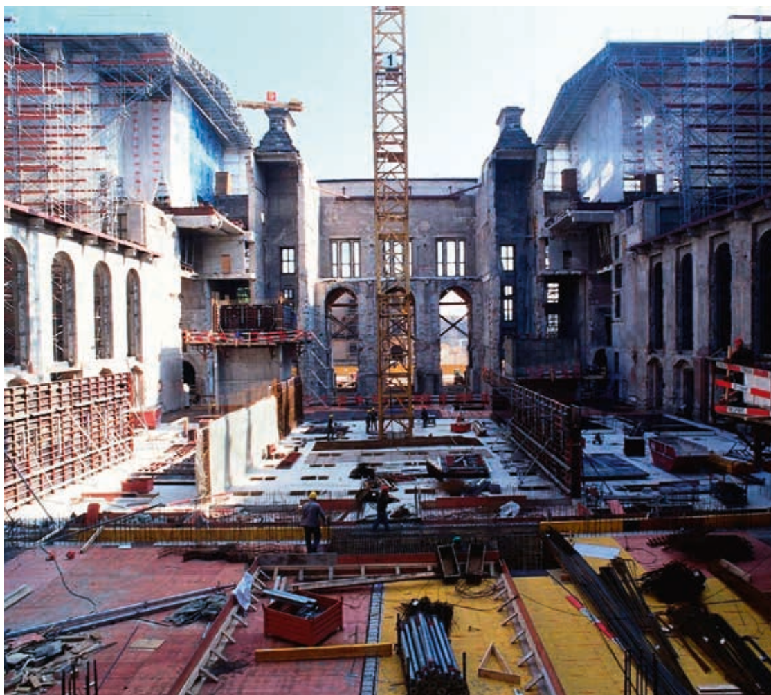
El edificio del Reichstag en obras durante la remodelación para el Bundestag Alemán, 10 de octubre de 1996.
