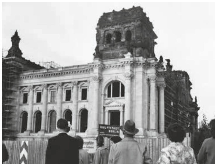
Vista de la parte sur de la fachada principal del edificio del Reichstag 1958, tras el saneamiento por la Dirección Federal de Obras.
